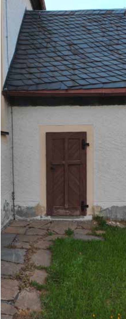
Sakristeitür von außen
